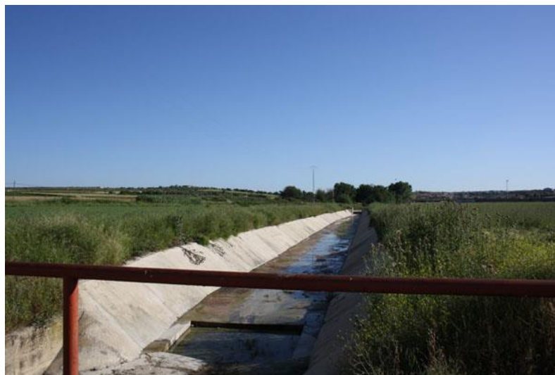
Encauzamiento del Arroyo de la Sal a su paso por el casco urbano. Elaboración propia.
